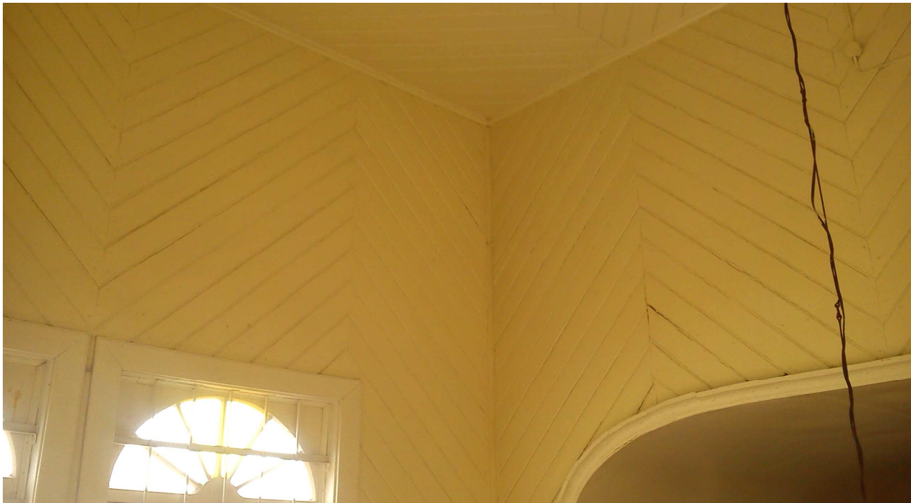
Zdj. 6. Widok ścian i stropu od wewnątrz. Deski są zniszczone, pokrzywione i zawilgocone. Gruba warstwa farby olejnej nie pozwala deskom wysychać.
