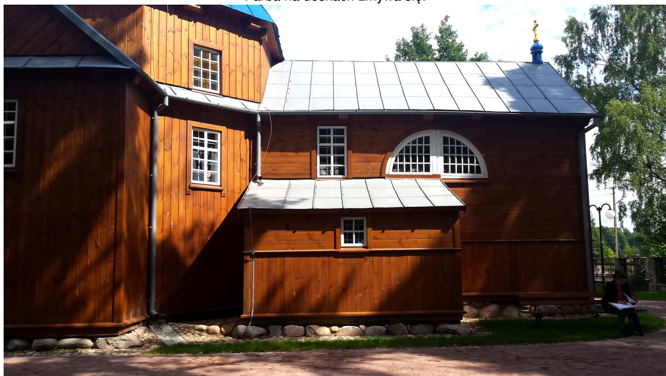
Zdj. 5. Część elewacji południowej. Cokół przy układaniu opaski rozpadł się. Został naprawiony częściowo przez ułożenie z powrotem kamieni luzem.
