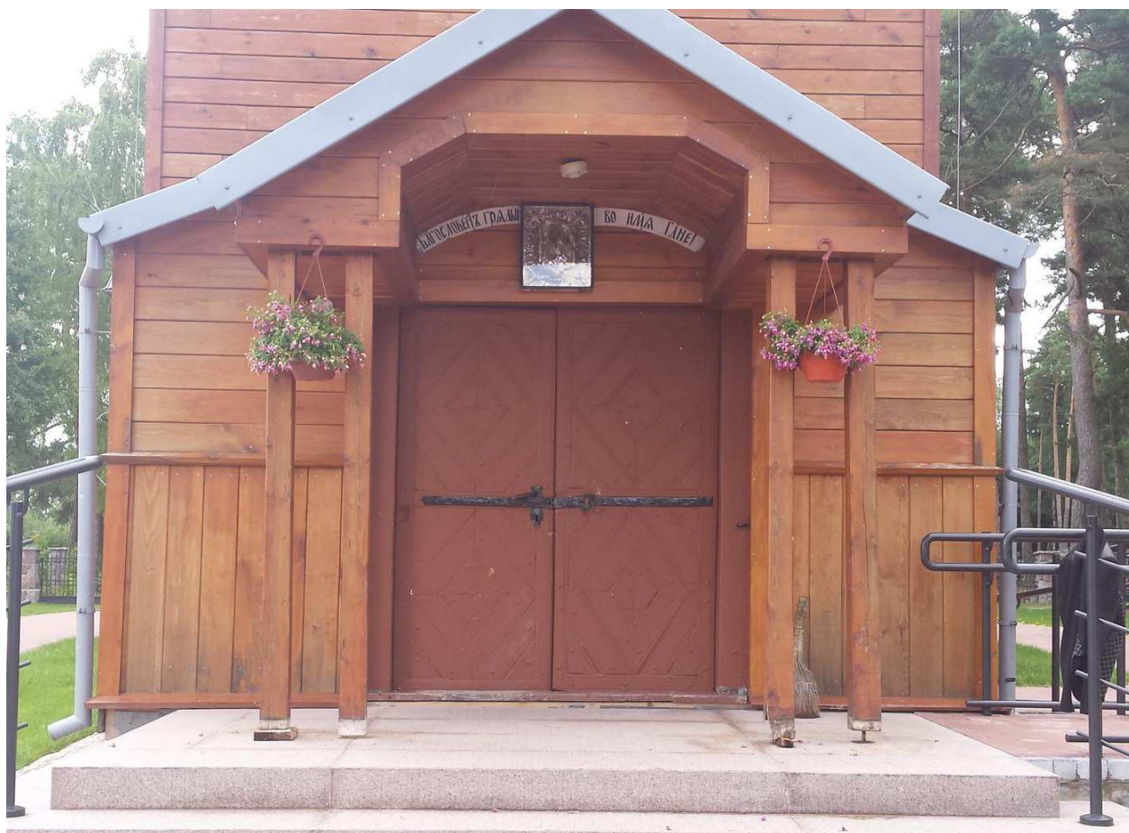
Zdj. 4. Elewacja zachodnia. Drzwi wejściowe przeznaczone do remontu (czyszczenia, naprawy i malowania) Farba na deskach zmywa się.
