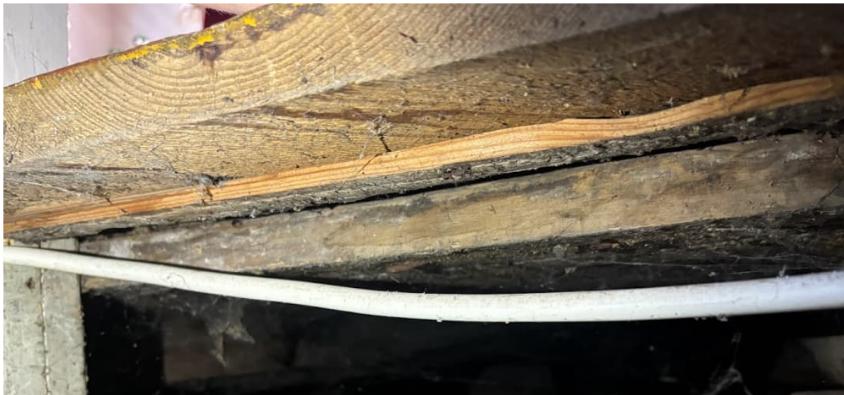
Zdjęcie 4 - Układ górnych warstw podłogi: deski ułożone wzdłuż i deski ułożone w jodełkę
