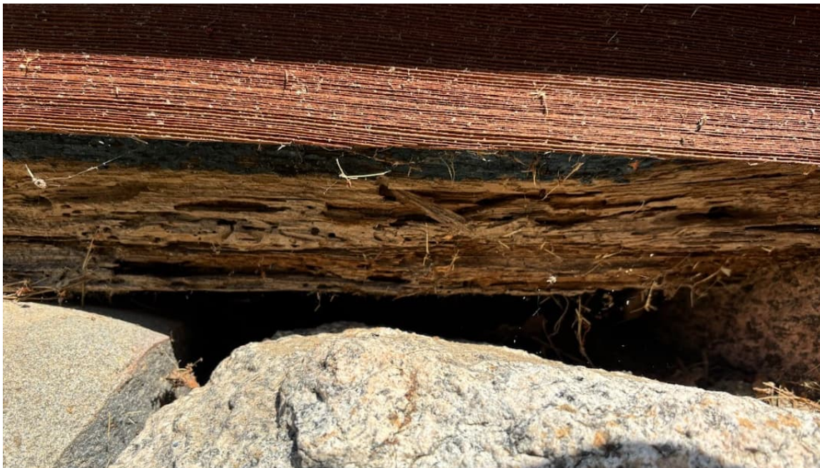
Zdjęcie 2 - Uszkodzona, spróchniała podwalina
