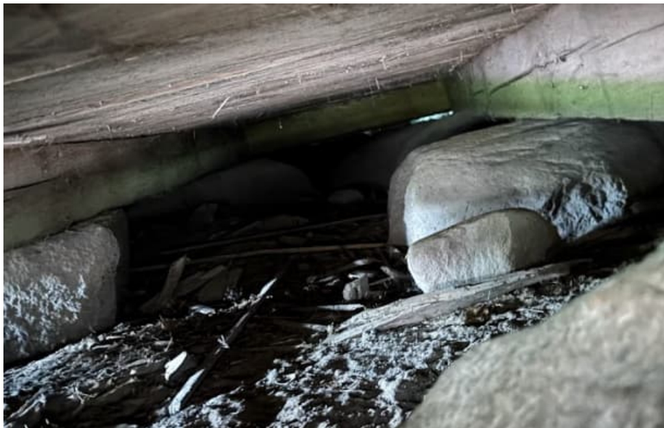
Zdjęcie 8 - Widok legarów oraz podwaliny w niższej części
