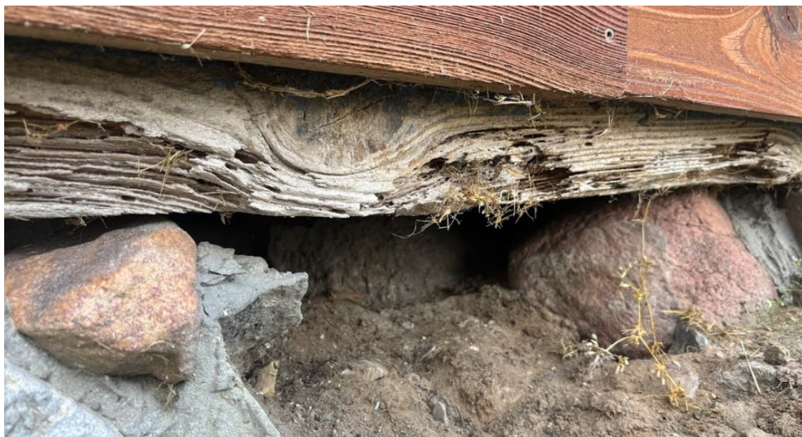
Zdjęcie 1 - Uszkodzona, spróchniała podwalina
